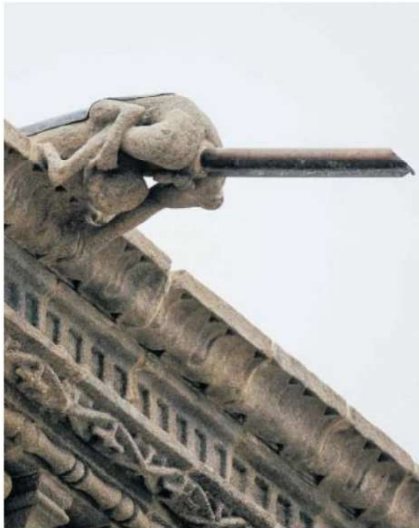
Boca de desagüe de la gárgola del Hostal dos Reis Católicos. ó. G.
